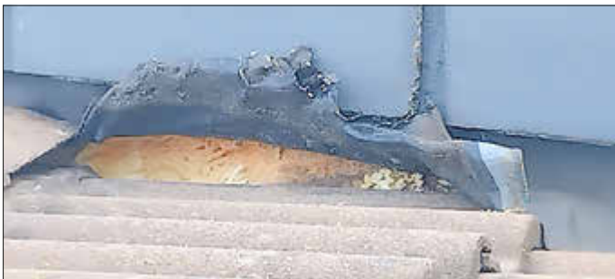
Ein durch Waschbären an einem Eigenheim auf der Petershöhe entstandener Dachschaden Foto: (c) privat
