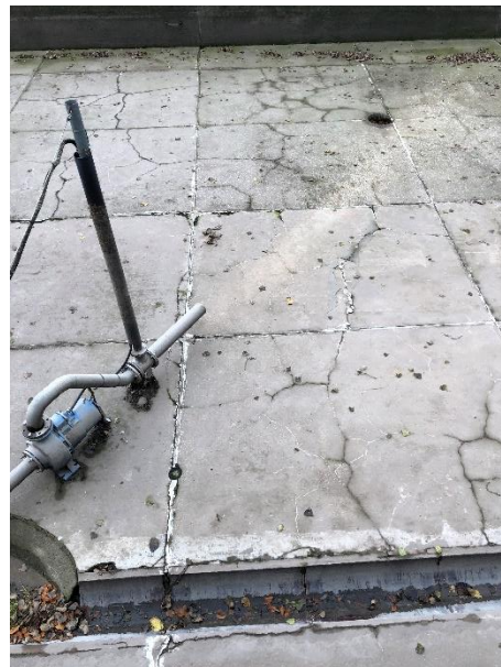
Schadhafte Betonoberfläche
